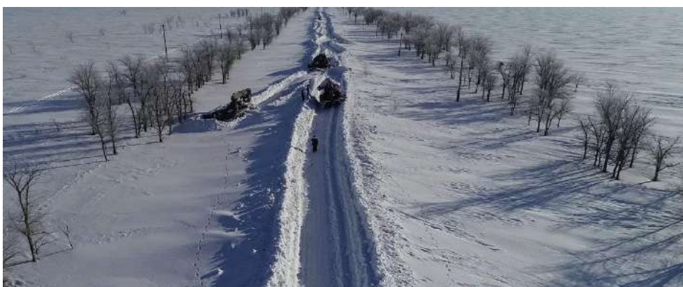
Рис. 3. Снежный занос на автомобильной дороге в Палласовском районе (фото из открытых источников)
