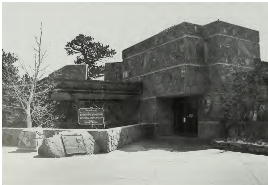
Рис. 3. Здание штаб-квартиры Taliesin Associated, США
