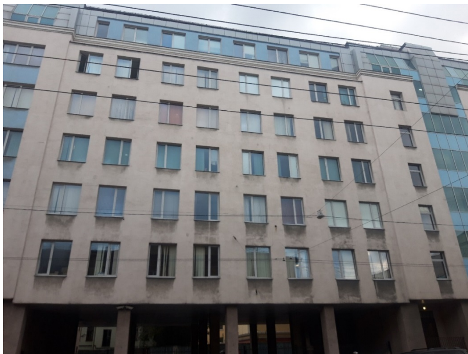
Рис. 8. Характерное распределение загрязнений на фасадах по высоте здания
