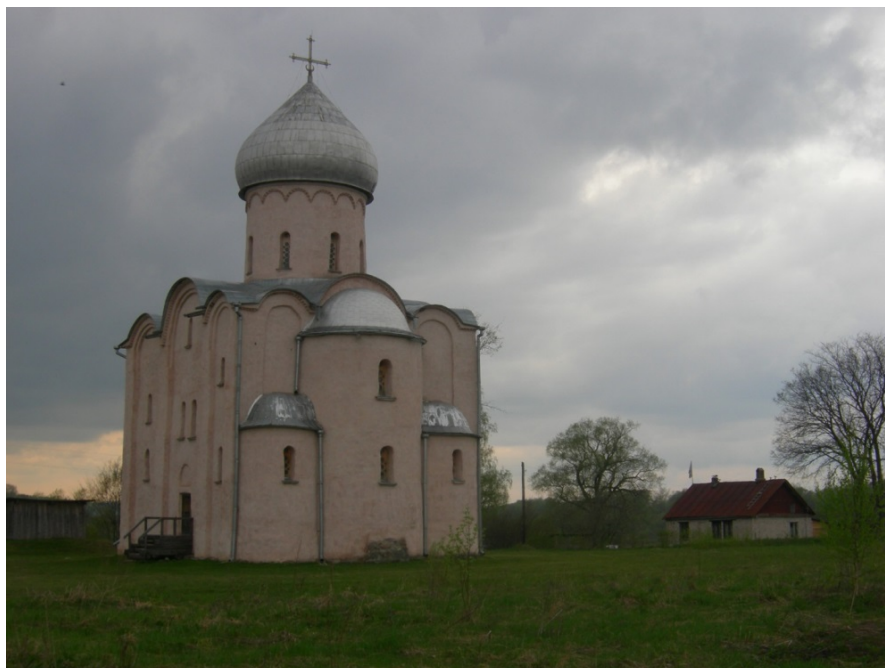
Рис. 2. Церковь Спаса на Нередице. Современное состояние. Фото: wikipedia.org
