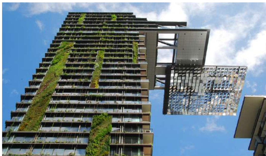
Рис. 9. Консольный гелиостат комплекса One Central Park в Сиднее, Австралия (архитектор Н. Фостер и партнеры, архитектурное бюро Жана Нувеля и PTW Architects)
