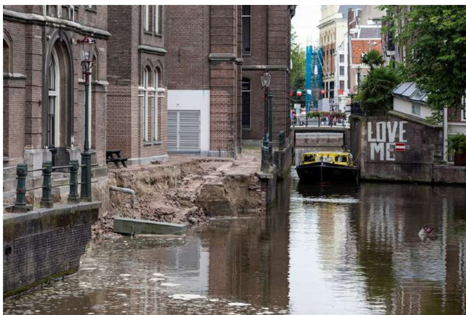
Рис. 18. Обрушение набережной на углу улиц Гримбургвал и Аудезидс Ворбургвал Университетского квартала, Амстердам (изображение Маартена Бранта)
